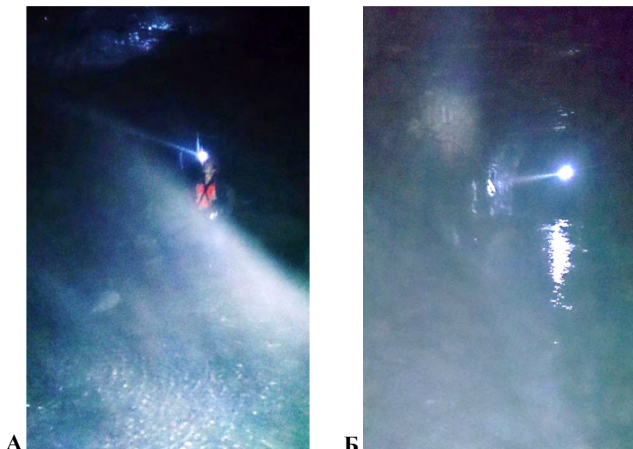
Рис.3. Фотографии 13 штрека. Наблюдается сильное обводнение штрека в виде водяной взвеси в атмосфере (А) и большого слоя воды на дне штрека (Б).
